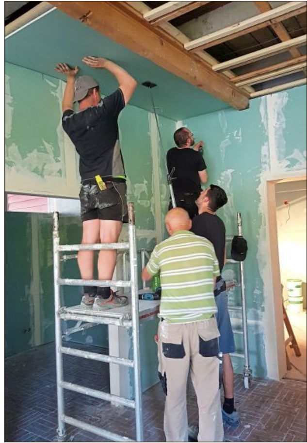
Nach 20 Jahren sind die Räume in die Jahre gekommen und mussten nun saniert werden.
