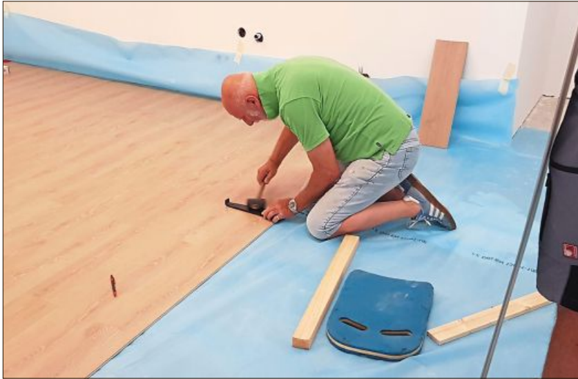
Auch den Boden verlegten die Wasserwachtler selbst.
