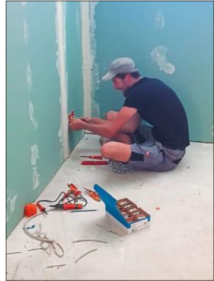
Knifflig: die Elektroarbeiten
