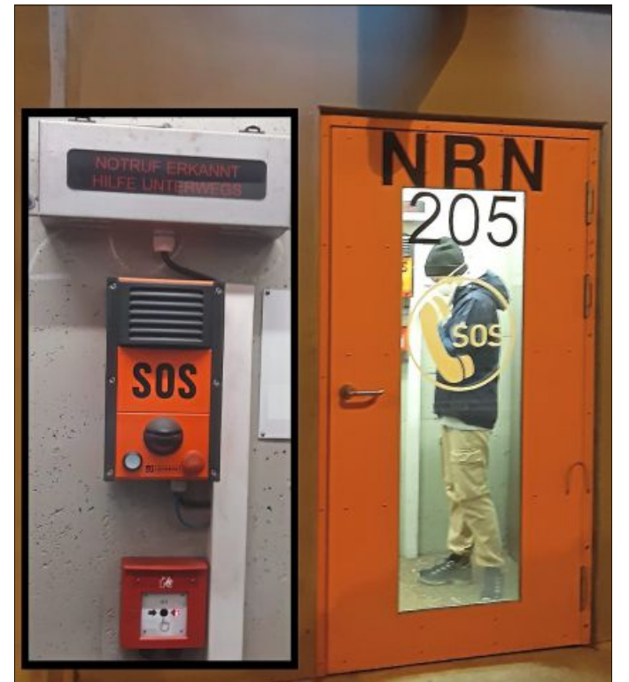
Der rote SOS-Knopf stellt eine Sprechverbindung zum Polizeinotruf her. Der Feuermelder darunter löst sofortigen Feueralarm durch die Integrierte Leitstelle Regensburg aus.
