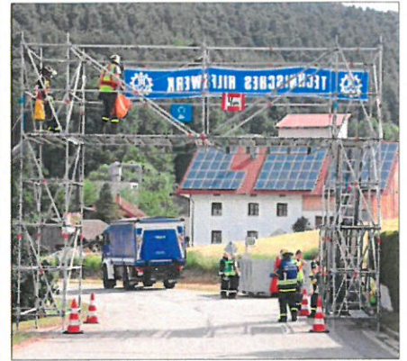
Gerüstkonstruktion des Technischen Hilfswerks am Ortszugang von Chamerau.
